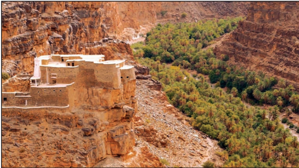
Fig. 1: Greniers Aguellouy d'Amtoudi, Anti-Atlas Occidental, versant saharien, après leur restauration de 2015-16 (par nos soins), Photographies en drone: Mehdi Benssid ©.
