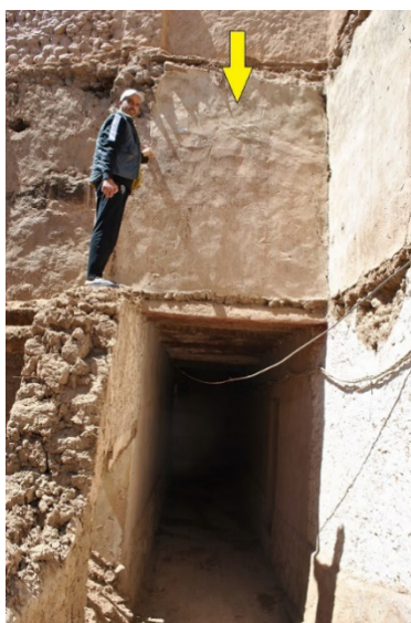
Fig. 1: Maison et chambre sur ruelle plafonnée (place Abdelkafi, Zenaga)
