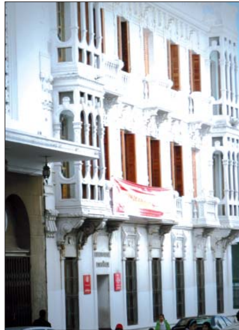
Fig. 5: Tétouan, façade coloniale 2 (Cliché Rachid Ouettassi).
