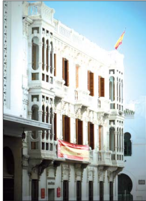
Fig. 7: Tétouan, façade coloniale 4 (Cliché Rachid Ouettassi)
