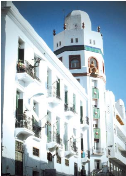
Fig. 4: Tétouan, façade coloniale 1 (Cliché Rachid Ouettassi).
