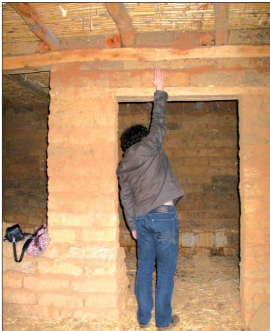
Fig. 6: Intérieur de la maison jebliya . Proportion et échelle humaines (Cliché de l'auteur).
