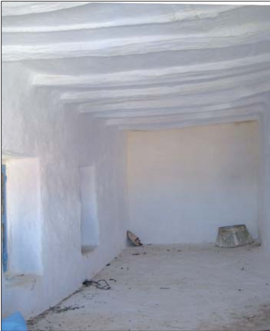
Fig. 7: Dār fuq akhtha , petite demeure connue comme la “maison au-dessus de sa sœur,” avec tous les parements revêtus de taḥnika (Cliché de l’auteur).
