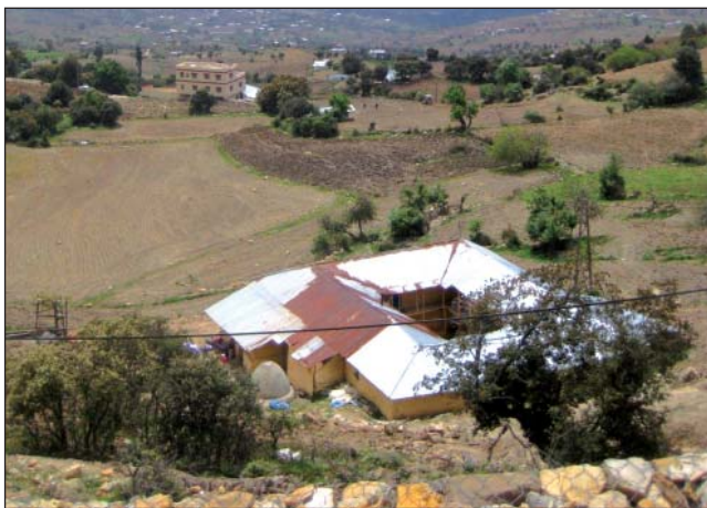
Fig. 1: Maison patio avec galerie intérieure, zone de Bab Berred (Cliché de l'auteur).
