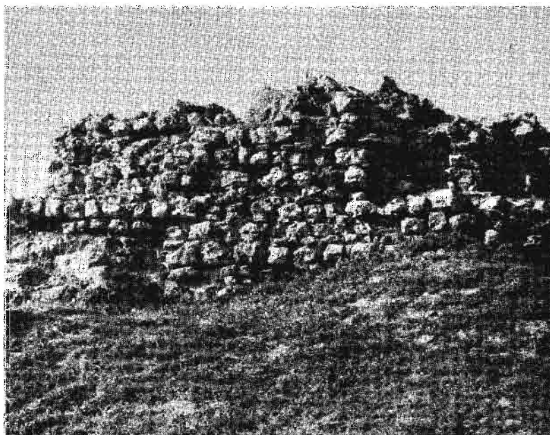
3. - Appareil du rempart sud à l'extérieur : moellons grossièrement taillés placés en lits horizontaux.
