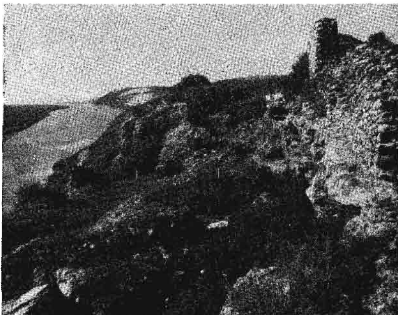
2. - A gauche, estuaire du Tensift et, au fond, le large. Dunes rive droite. Au premier plan, la corniche calcaire s'est effondrée à l'emplacement d'une cavité peut-être naturelle. Muraille surplombant la corniche.
