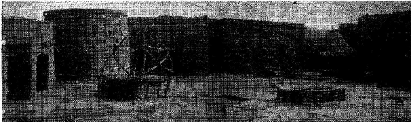
32. Qaṣr El-Bārka (Tagānt). — La maison-entrepôt des Ghūdf. A gauche, tour-grenier percée de rangées de trous d'aération.
