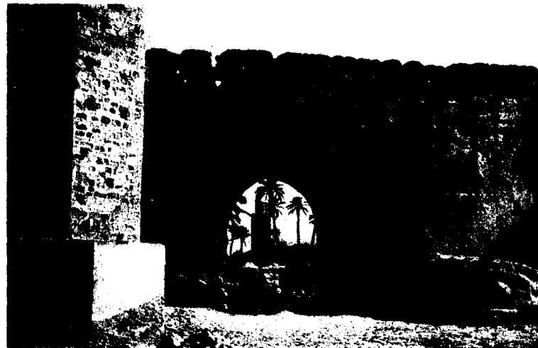
b - Bab el-Makhzen : La baie vue de l'extérieur à la fin des travaux.
