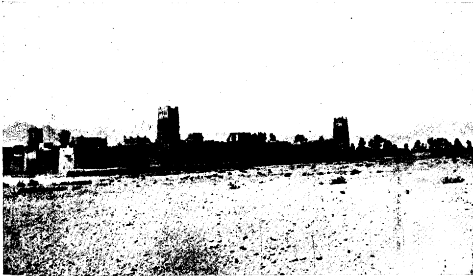
Igherm des Ait-Atto : il est clos d'une double enceinte flanquée aux angles de hautes tours formant saillant sur deux côtés ...
