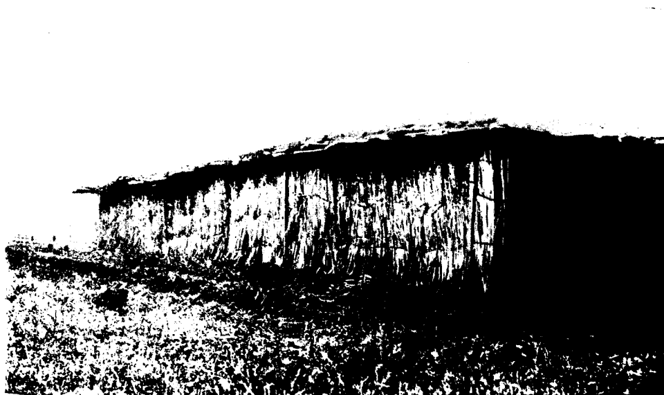
... La partie exposée aux pluies de l'Ouest est revêtue d'un clayonnage de jonc et de paille de marais...
