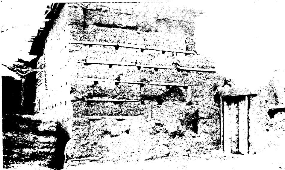
... on répare le mur de pisé en encastrant dans la construction des traverses de bois qui limiteront les effondrements...
