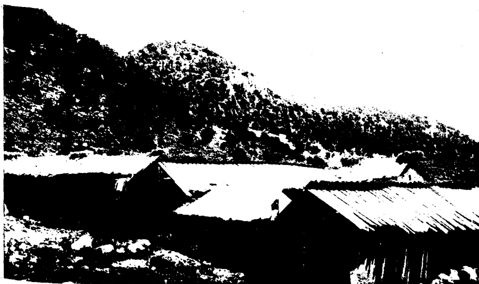
... les larges planches de cèdre qui forment le couvert sont de longueurs inégales et débordent le haut des murs qu'elles protègent ainsi...
