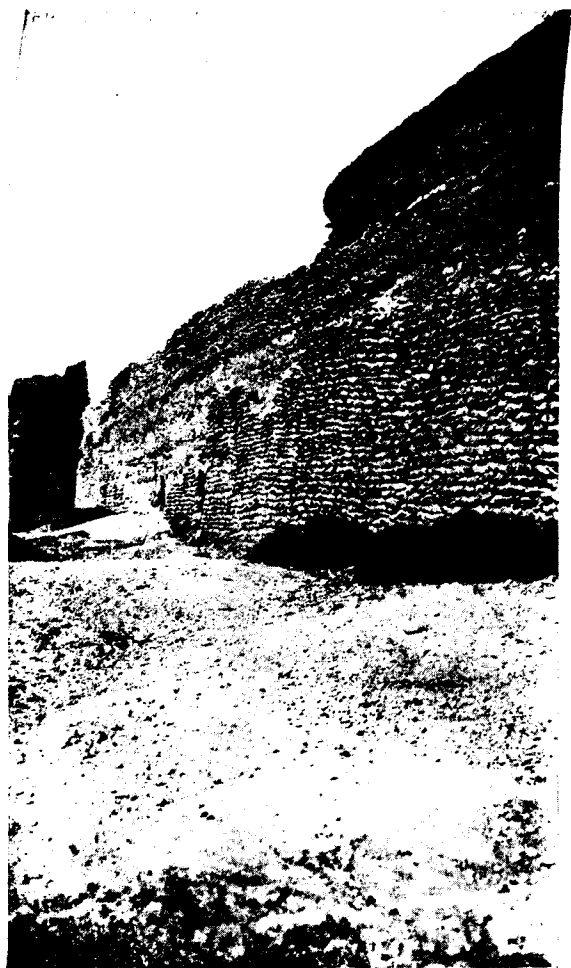
... le mur d'un ighrem de la Haute-Moulouya a été restauré par un placage de pierres adossé à la muraille de pisé.
