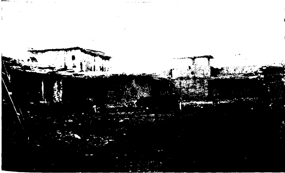
... les maisons de l'ighrem des Aït ben 'Atto sont adossées aux murs de l'enceinte de manière à ménager à l'intérieur une grande cour à l'usage du bétail...
